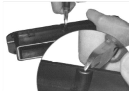
2. Si nécessaire libérer un passage de câble
